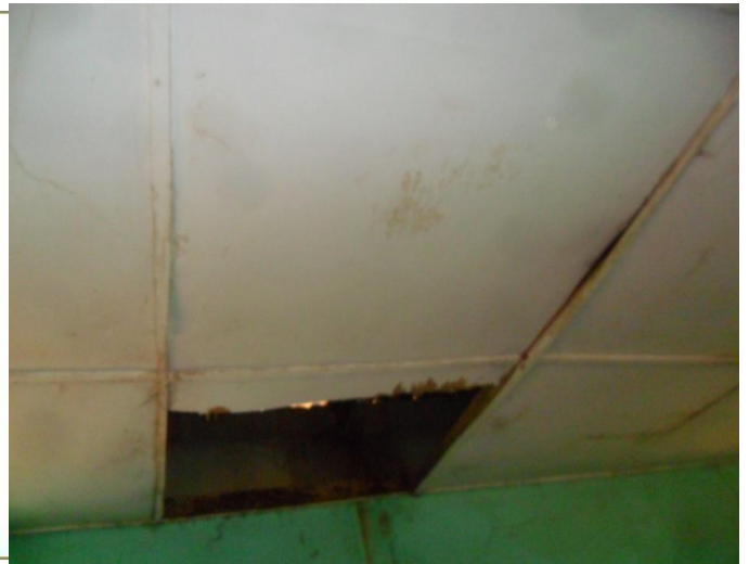
Dégâts au contre plafond du dortoir endommagé
