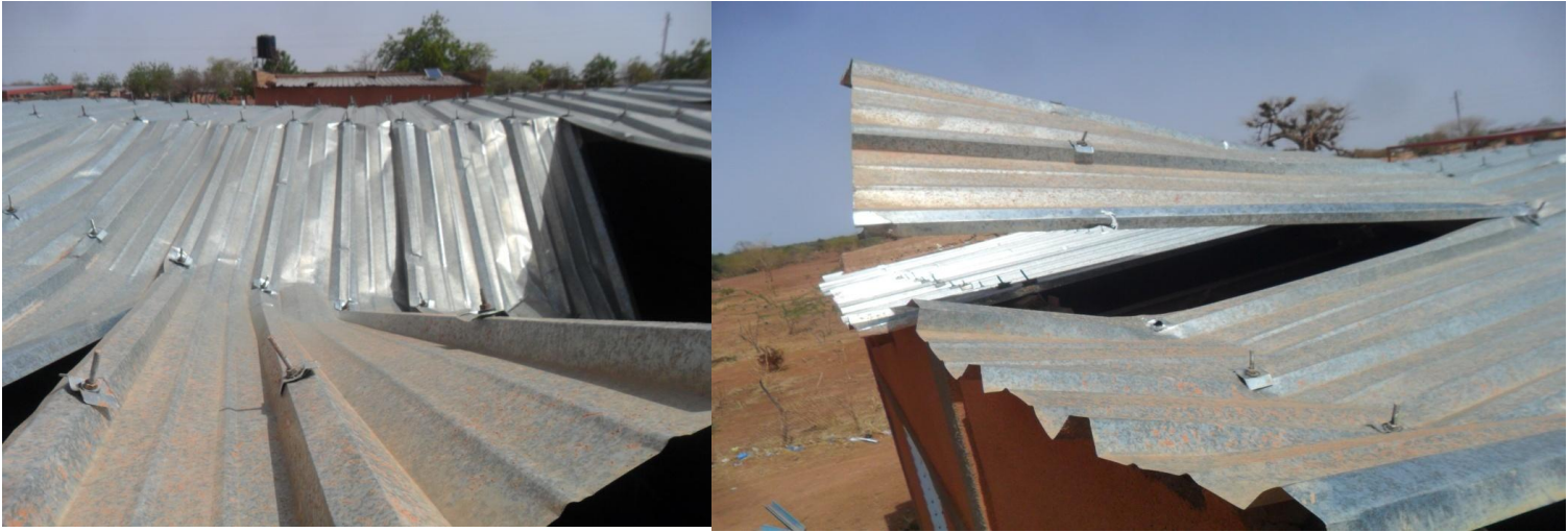
Photo vue au-dessus du réfectoire
