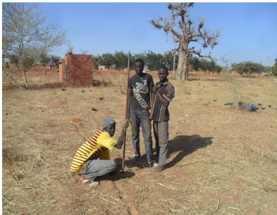
Creusement de base des poteaux
