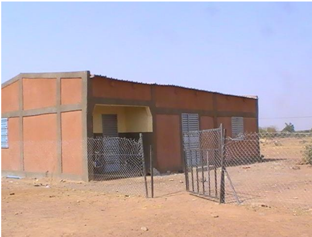
Porte à l'accès vers la cuisine et la pompe
