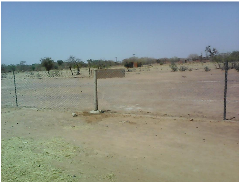
Poteau en béton (renfort 1 sur 2) ; le treillage est aussi bétonné au sol.
