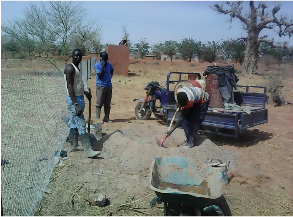
Pose du grillage suivit de béton
