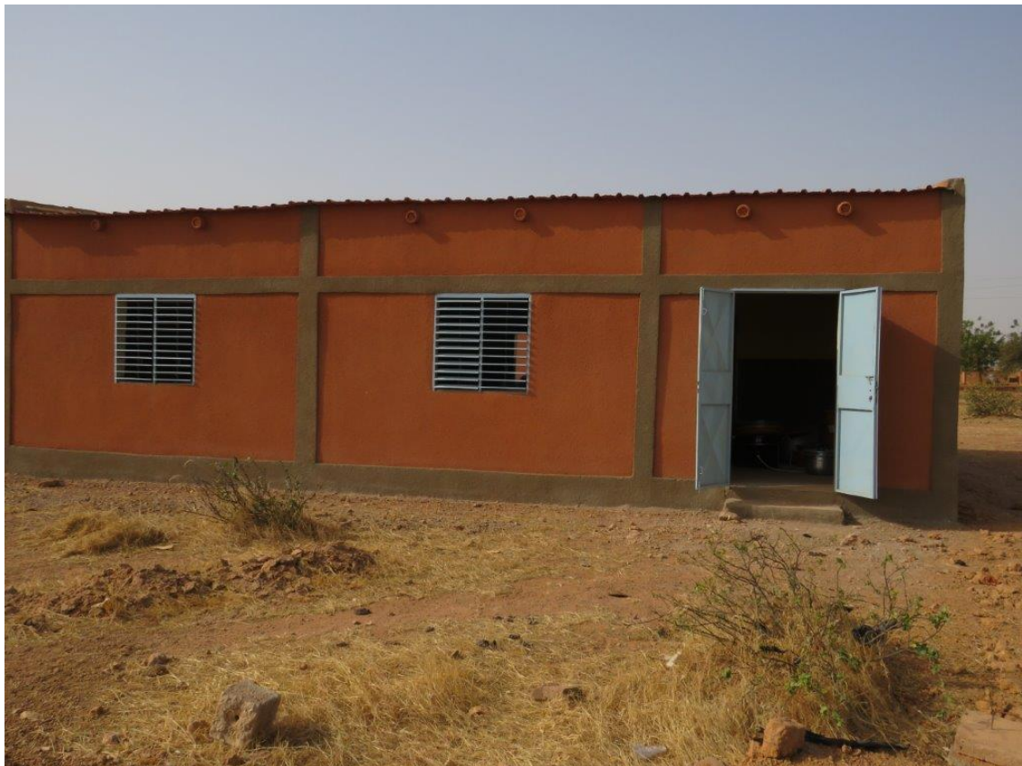
Réfectoire vue arrière et porte du magasin de la cuisine
