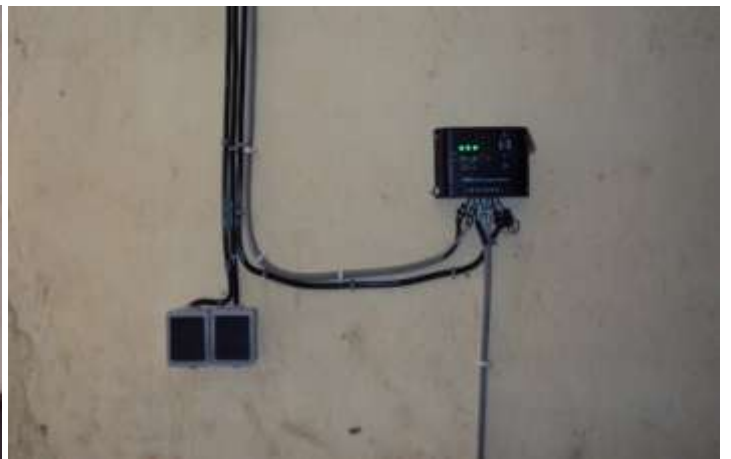
Coffret de batterie et convertisseur 300W pour recharge des portables - 1 er dortoir
