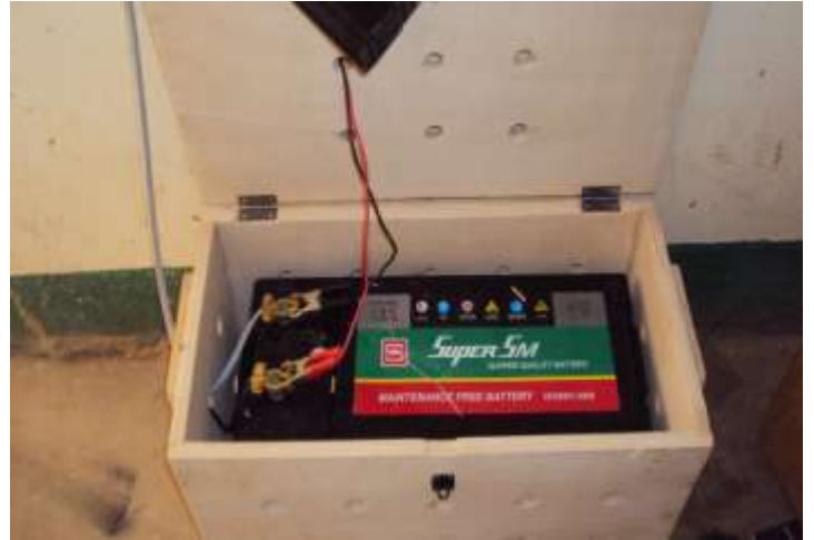
Coffret de batterie et convertisseur 300W pour recharge des portables - 1 er dortoir
