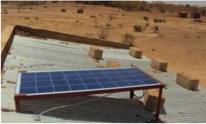
Panneau solaire de 150w sur le toit du dortoir de 6 lits. A droite deux bâtiments de latrines-douches. Le futur réfectoire sera alimenté par ce panneau solaire
