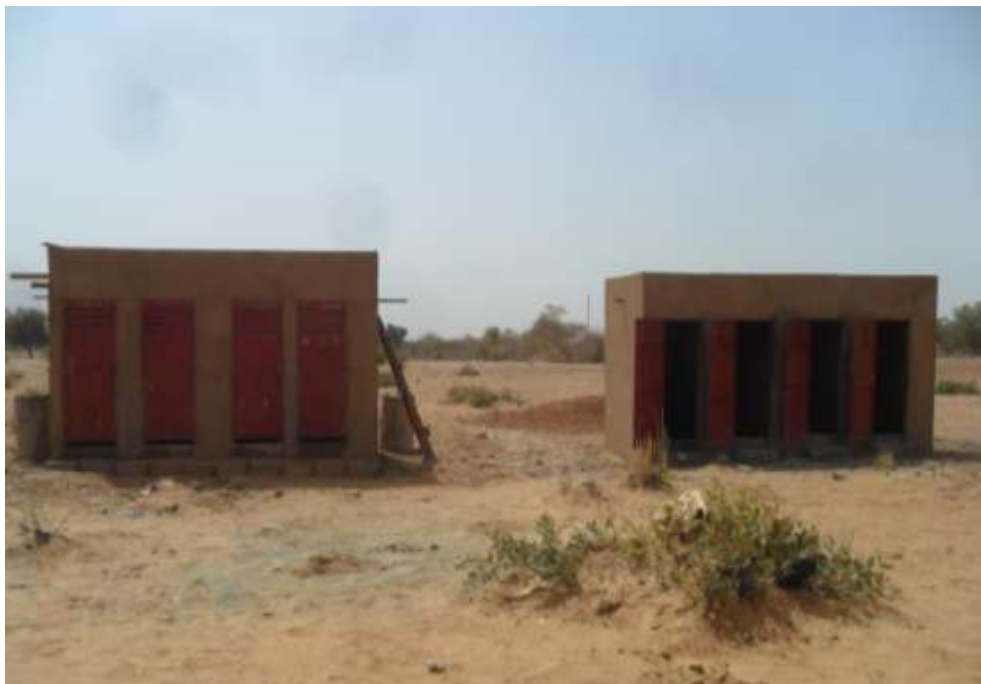
Construction du second bloc latrines-douche en cours.
