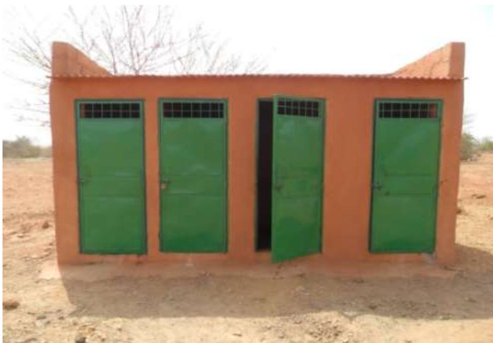
Un groupe de latrines-douches terminé
