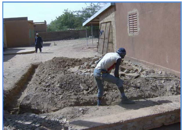
Préparation des fondations en vue de l'agrandissement de la banque de céréales (photo décembre 2012)
