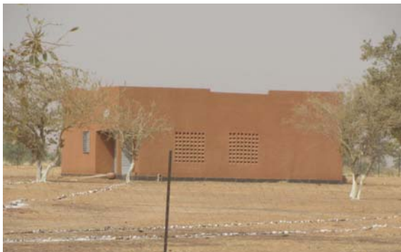
Bâtiment de la maternité
